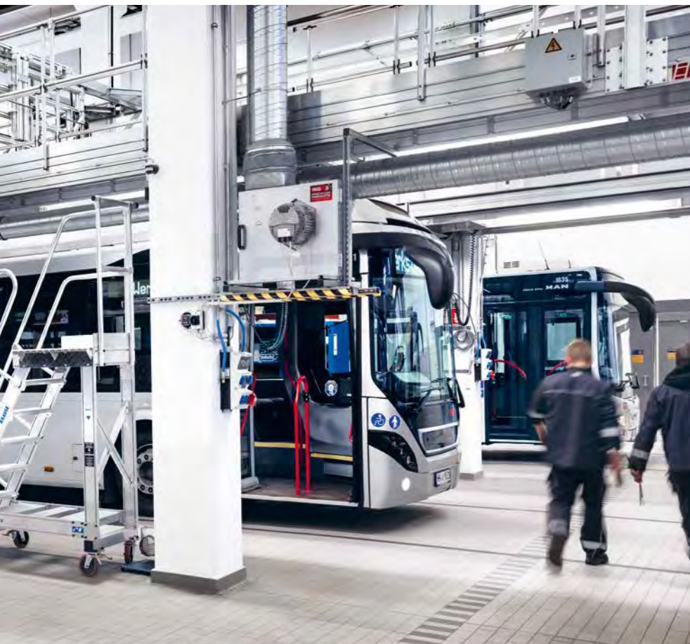
Umbau: Eine neue Werkstatthalle ermöglicht Arbeiten auf dem Dach.
